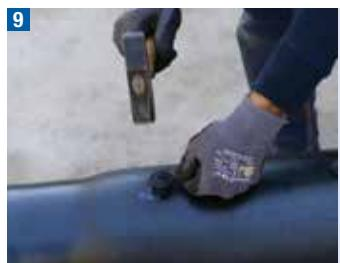
Placez les deux bouchons de polymérisation fournis, en vous assurant que le capot d'évent n'est pas enfoncé dans le trou. Attendez donc environ 5 à 10 minutes, en fonction de la température extérieure, pour que le mélange introduit se transforme en mousse.
