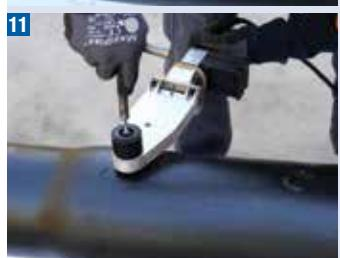
Passez à la soudure des bouchons de fermeture fournies par polyfusion en respectant les temps de fusion et de refroidissement.
